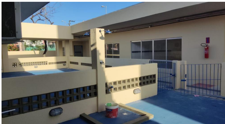
Figura 3. Espaço ampliado, com novas salas após a reforma realizada pela prefeitura.
